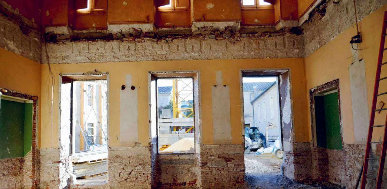
Le palais épiscopal vu de l'intérieur.
