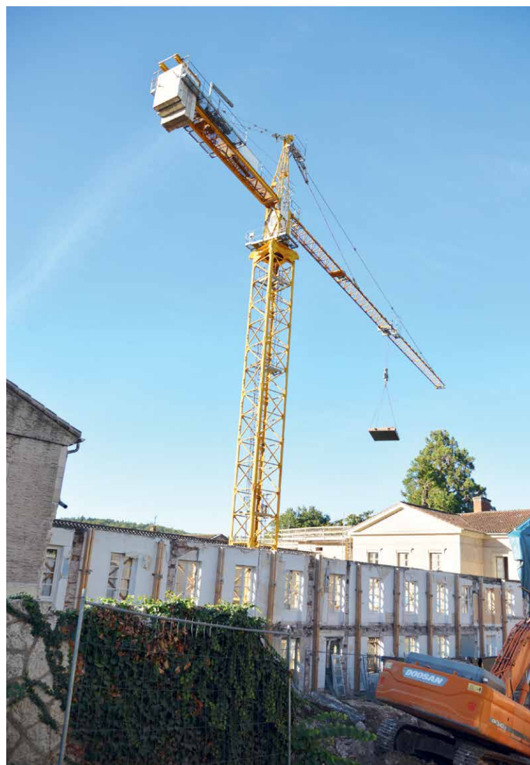
Le chantier en cours.
